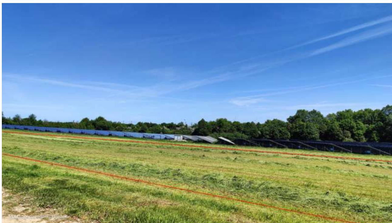
Bild 2.1.5: Foto der PV Fläche (Quelle: SolPEG)
