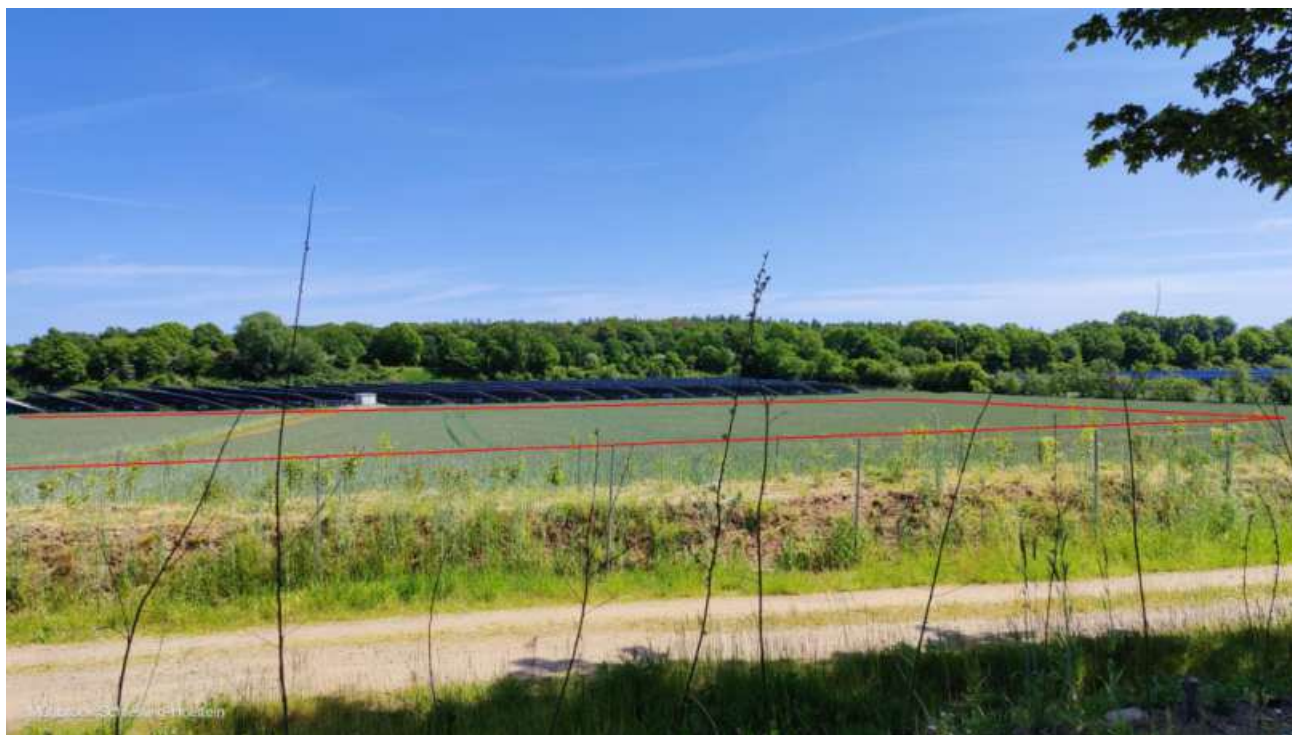
Bild 2.1.4: Foto der PV Fläche (Quelle: SolPEG)
