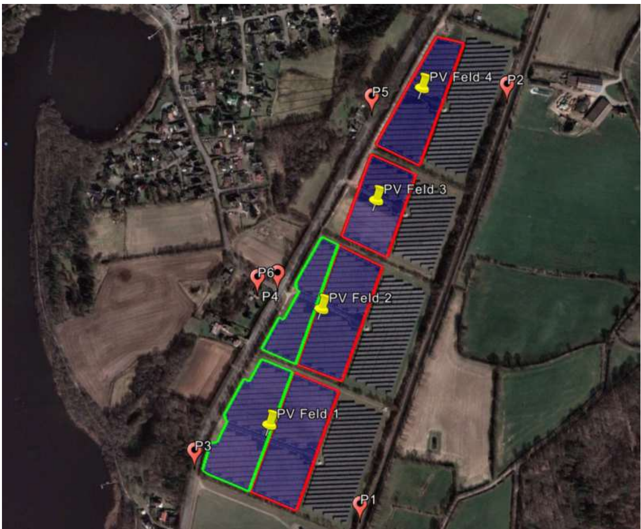
Bild 3.5.1: Übersicht über die PV Anlage und Messpunkte (Quelle: Google Earth/SolPEG)
